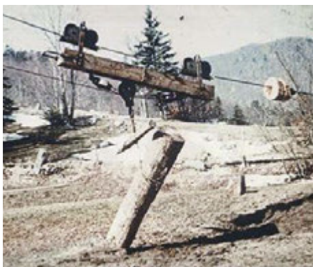
Naletni zaustavljač na spodnji postaji in voziček z dviznim škripčevjem
